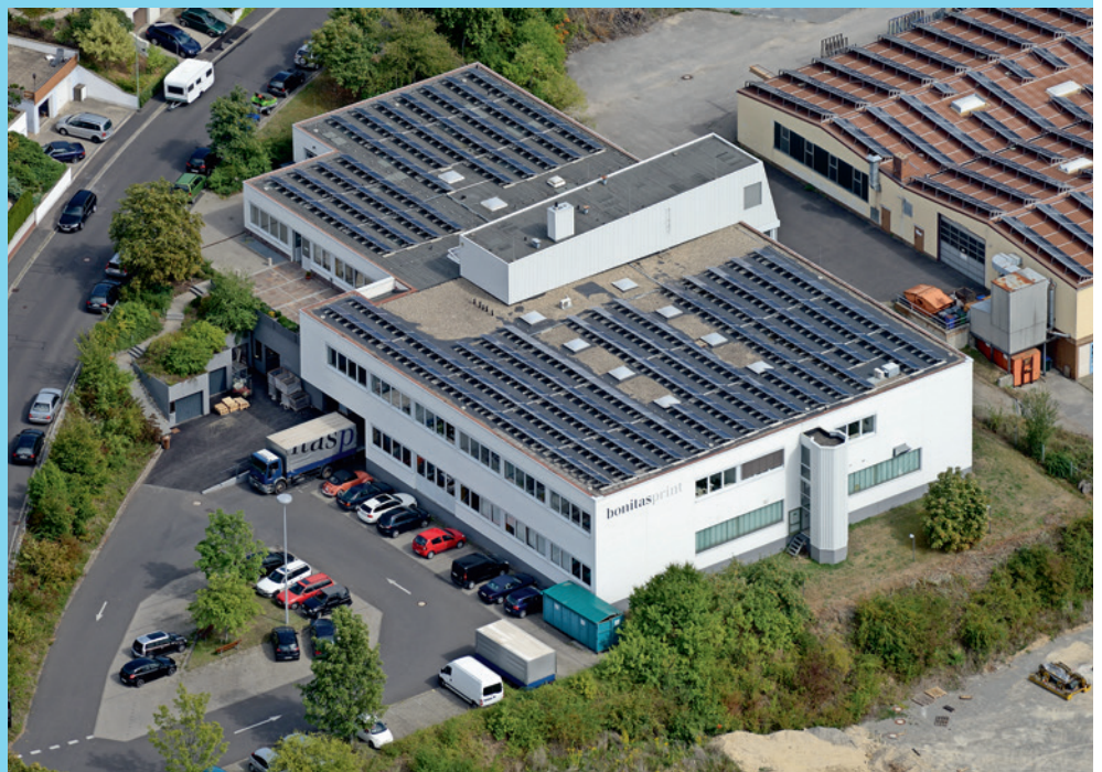
PV-Module auf dem Dach der Druckerei.
