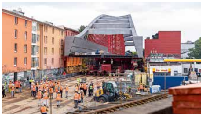
3.700 Tonnen schwer, 108 Meter lang, 1.088 Räder – der Spezialtransport der neuen Sternbrücke in Hamburg.
