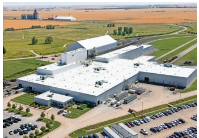
Der Knauf-Standort in Kanada: In Wheatland im Bundesstaat Alberta wurde ein neues Gipsplattenwerk eröffnet.
