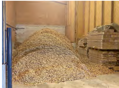
Biomasseheizanlage und PV-Module machen den Brückenbaron fast völlig autark.
