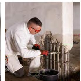
Fehlt die Beschichtung in Parkgaragen oder ist diese schadhaft, dringen Feuchtigkeit und Salze in den Bodenaufbau ein. ISOTEC bietet rissüberbrückende Garagenbodenbeschichtungen und Instandsetzung von Betonbauteilen sowie Anti-Schimmelbeschichtungen für Wände und Decken aus einer Hand. Wenn es schnell gehen muss, sind Sanierungen in Teilabschnitten und kurze Ausfallzeiten mit schnell abbindenden Materialien möglich.
