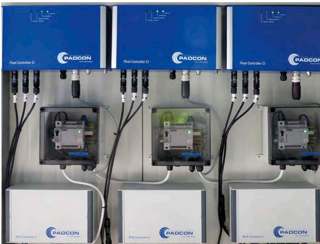
Installationsbeispiel: Installierte Float Controller CI zur Optimierung bzw. Regenerierung von degradierten PV-Modulen.
