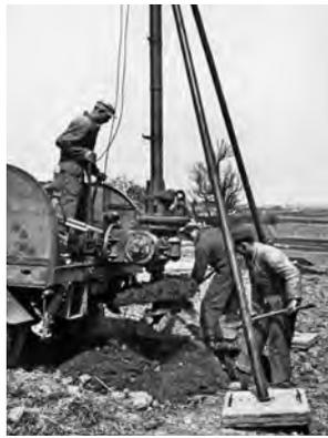
Bohr- und Stellgerät für die Aufrichtung von Strommasten, 1950.
