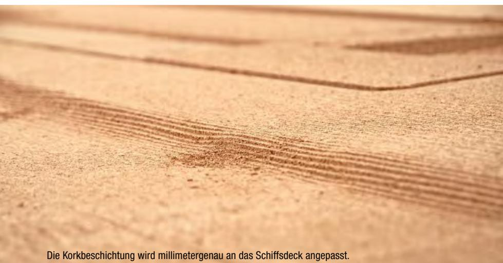
Die Korkbeschichtung wird millimetergenau an das Schiffsdeck angepasst.
