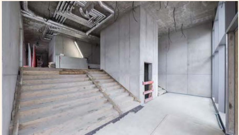
Die Ausführung des Rohbaus erfolgte komplett in Ortbeton, wobei 50% der Betonflächen in Sichtbeton umgesetzt wurden. Sichtbetonflächen und sichtbare Haustechnikleitungen sollen den modernen Industriecharakter des Gebäudes unterstreichen. Das Foto zeigt den zukünftigen Eingangsbereich des Studentenwohnheims.
