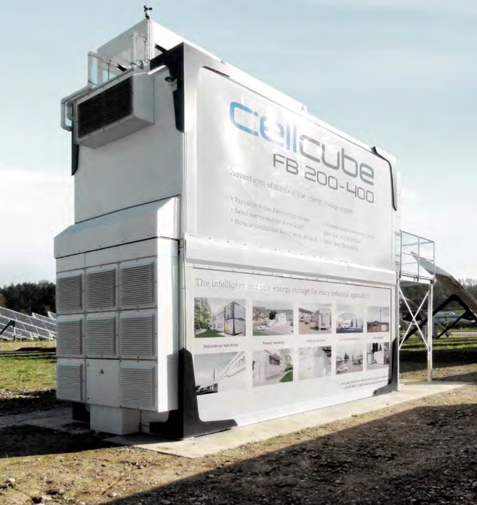
Der „CellCube FB 200-400“-Energiespeicher verfügt über eine Leistung von 200 kW und eine Speicherkapazität von 400 kWh. Ist er voll geladen, wäre der CellCube in der Lage, 40 Haushalte 24 Stunden lang mit Energie zu versorgen.
